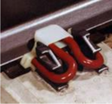
ნახ. №12. შუალედური “Pandrol”-ის ტიპის სამაგრები რკინაბეტონის შპალებზე.
